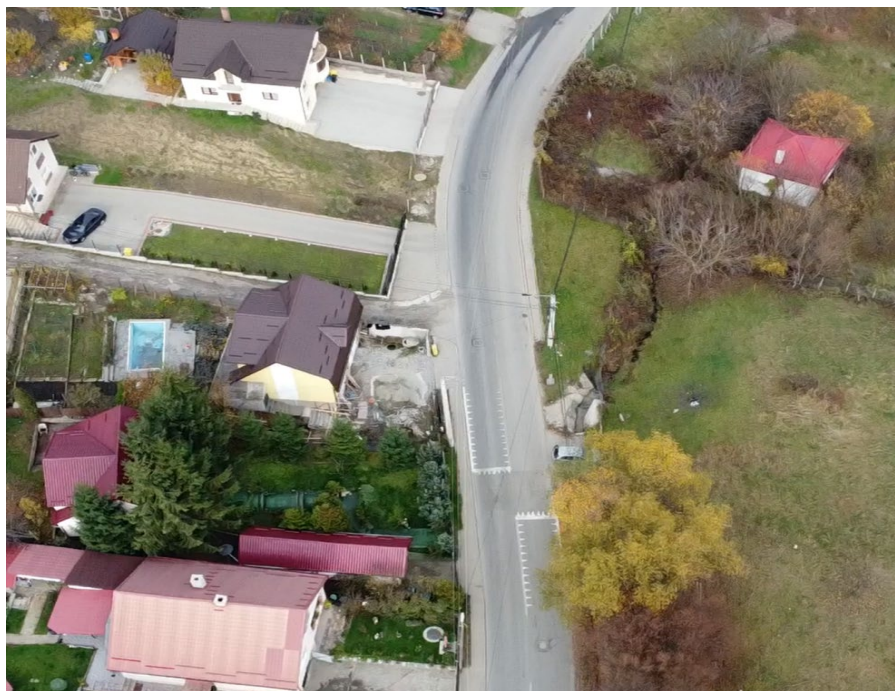
Imagine 5.33 Capăt aval rigolă betonată str. Valea Budacului amonte str. Lempes
