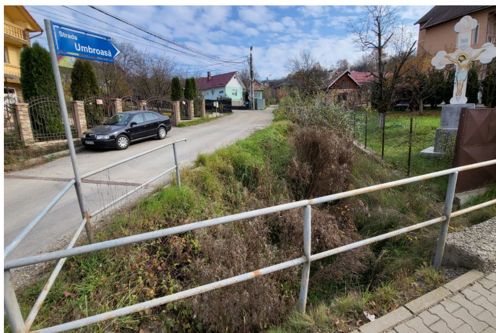
Imagine 5.14 Rigola str. Umbroasă amonte str. Valea Budacului
